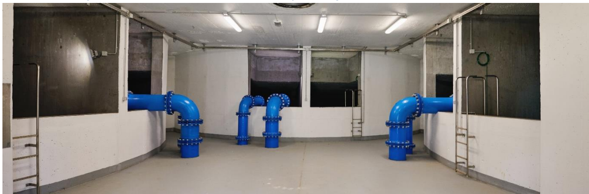
Slika 5: Notranjost vodohrana Zeleni hrib na Brdu pri Kranju
