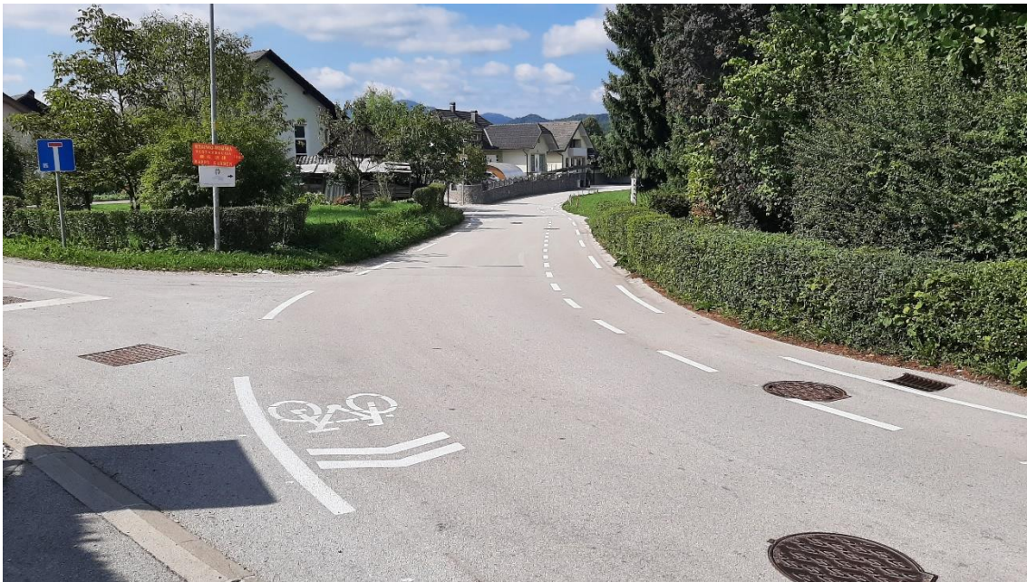
Nove kolesarske površine v Bitnjah – desno kolesarski pas na vozišču, levo ureditev na način souporabe (»sharrow«)
